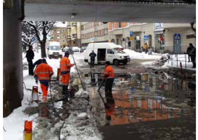
Viadukten under järnvägen vid Östra Kanalgatan vintern 2001. Pumpar som ska pumpa bort vatten från viadukten fungerar inte.
