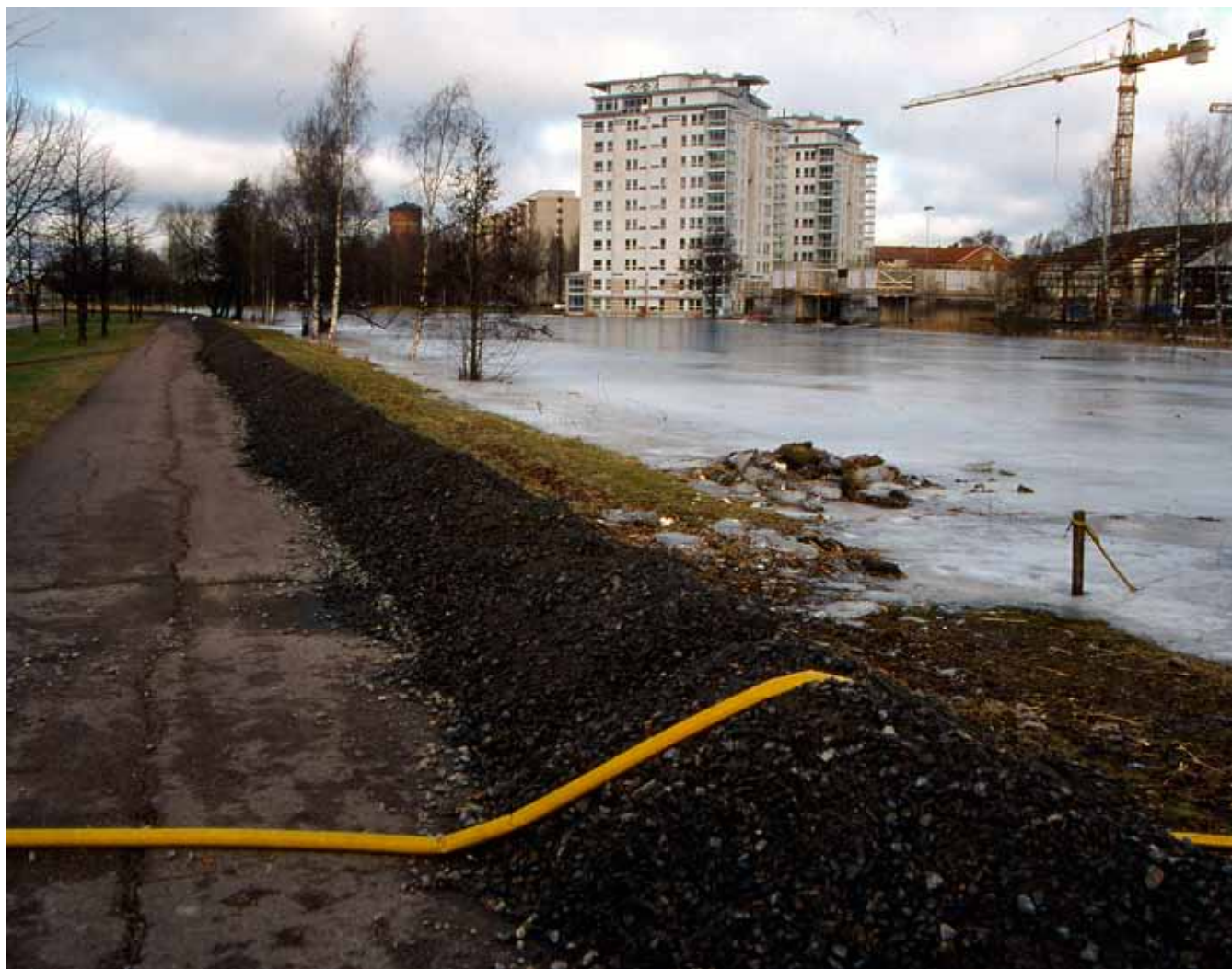
Foto från Kanikenäsbanken våren 2001. Till höger pågår arbete med utbyggnad i kvarteret Vågmästaren. I bakgrunden skymtar fd Herrhagens vattentorn. Delarna runt Inre Hamn hör till de lägsta delarna i Karlstad och kommunen byggde vallar med pumpar för att skydda området från översvämning.
