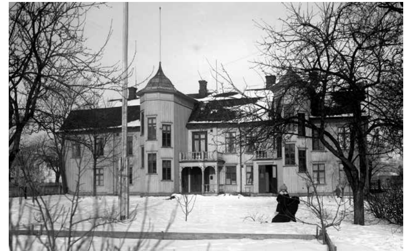
Grevgården 1922, med trapphus försedda med spetsiga tak, som senare togs bort. FOTO: KARL NYSTRÖM
