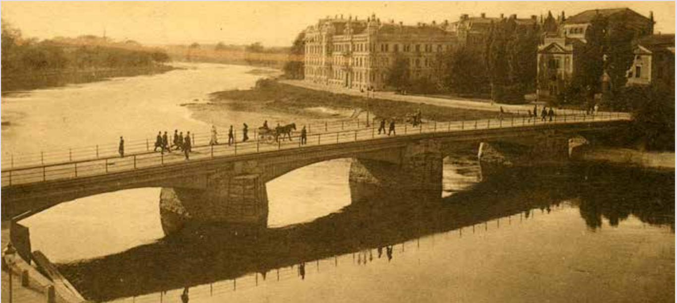
Västra bron från ett vykort poststämplat 1915.
