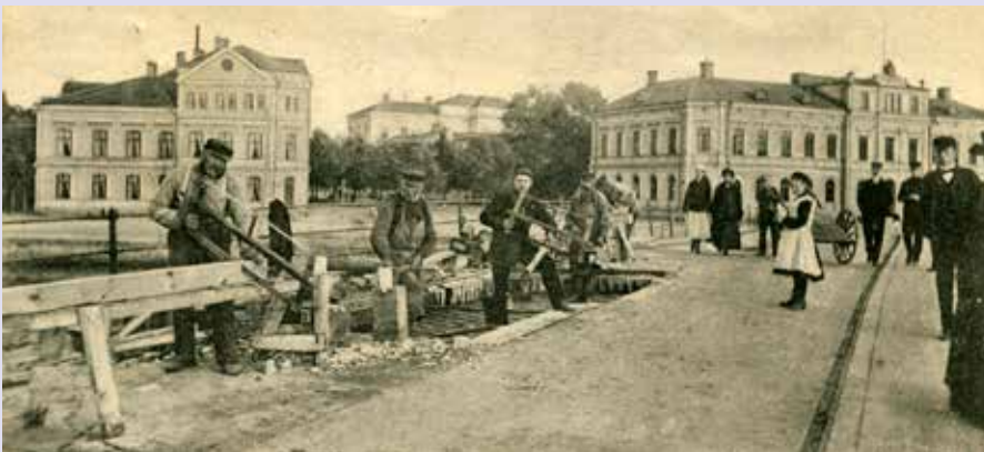
"De fem gubbarna på bron", som sommartid arbetade med att byta ut de tvärställda tråkubbarna i vägbanan. Flanerande stadsbor brukade stanna till och titta på.
