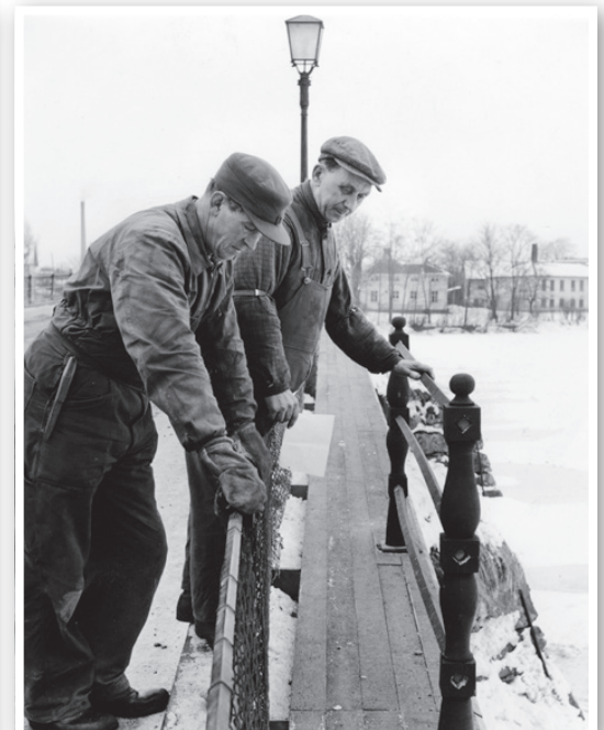
Östra bron repareras 1956.
