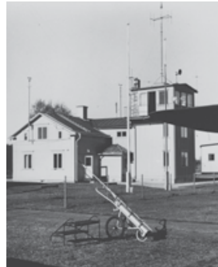
Flygplatsbyggnaden med påbyggt flygledartorn.
