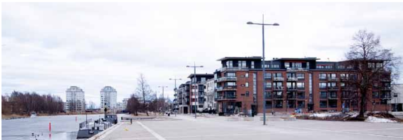
Vågmästaren och Inre hamn har byggts efter det att marken konsoliderats.
