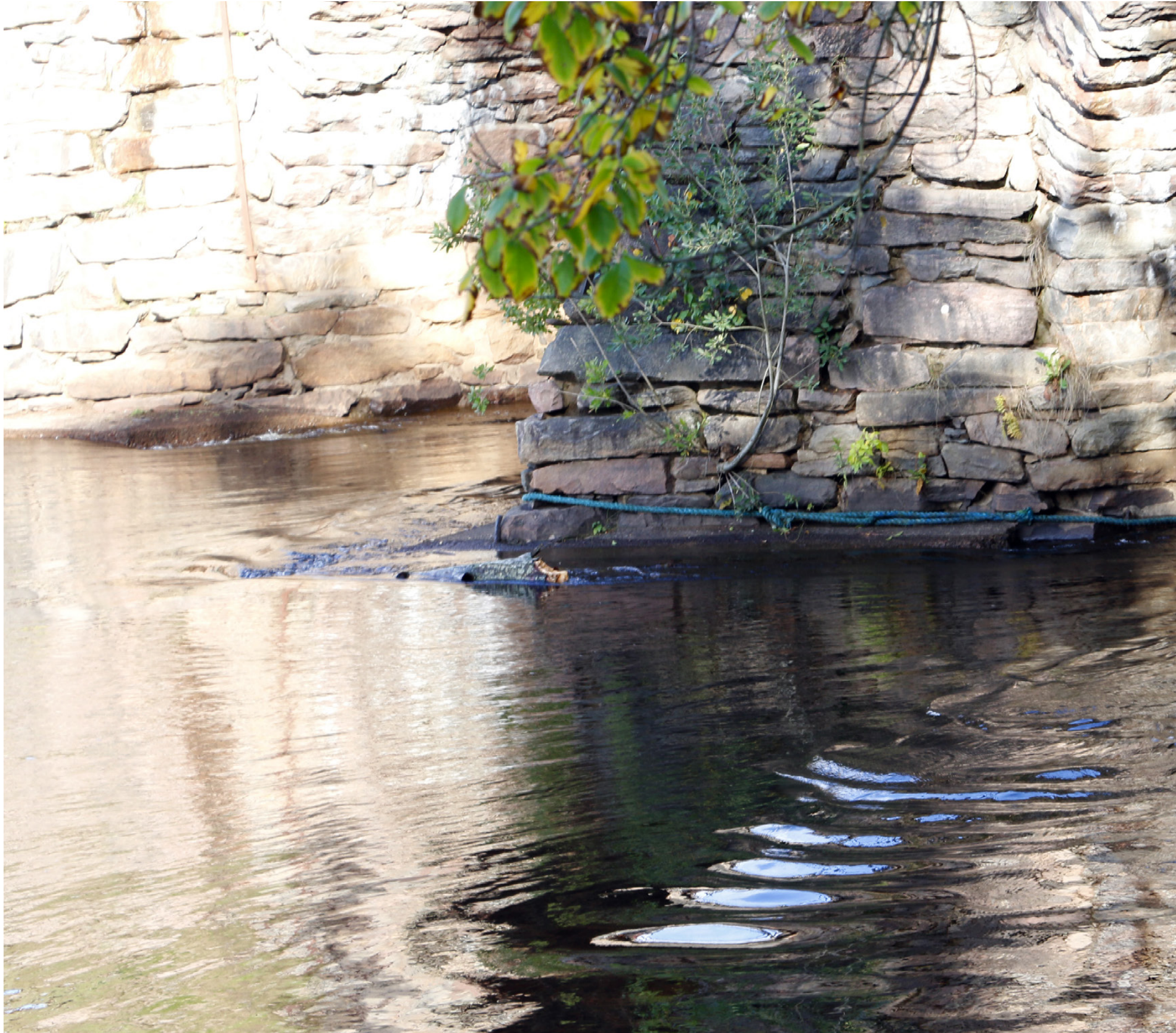
När KT kom tid arbetade en dykare under vatten med fundamenten.
