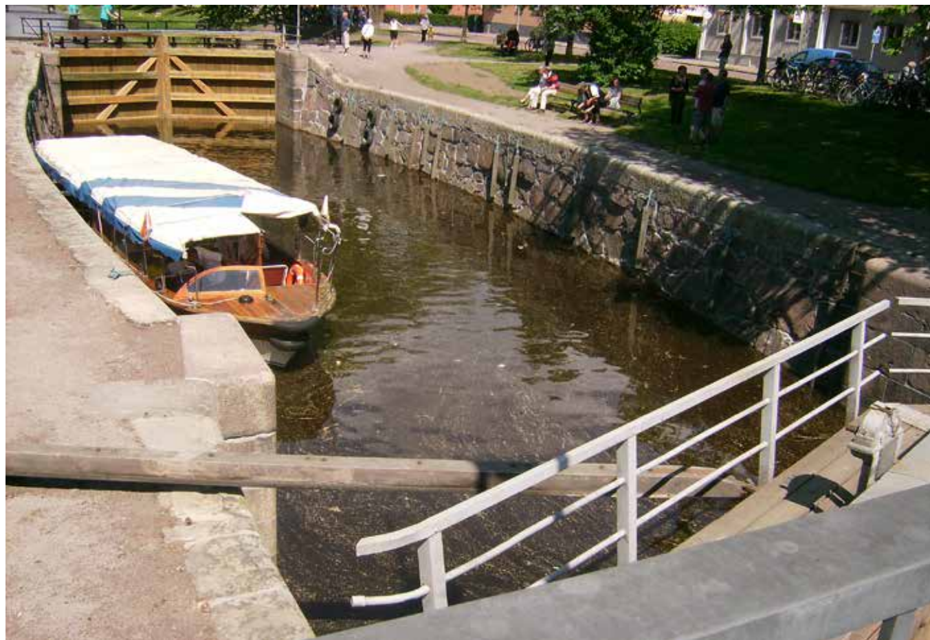
Pråmkanalen den 1 juni 2013. Lagom till 175-årsjubileet byttes de gamla slussportarna ut mot nya fräscha. Foto: Marie Aakre
