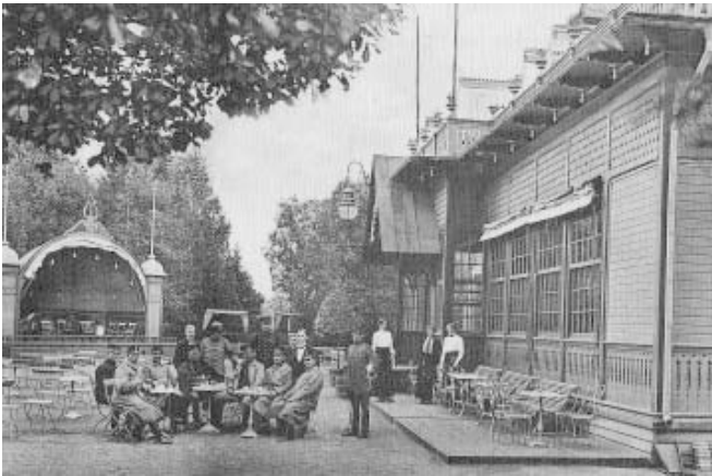
Den andra restaurangen i ursprungligt skick utan veranda. Till vänster i bilden syns den år 1893 byggda musikpaviljongen. Militärerna, förmodligen musiker, intar förfriskning före en konsert
