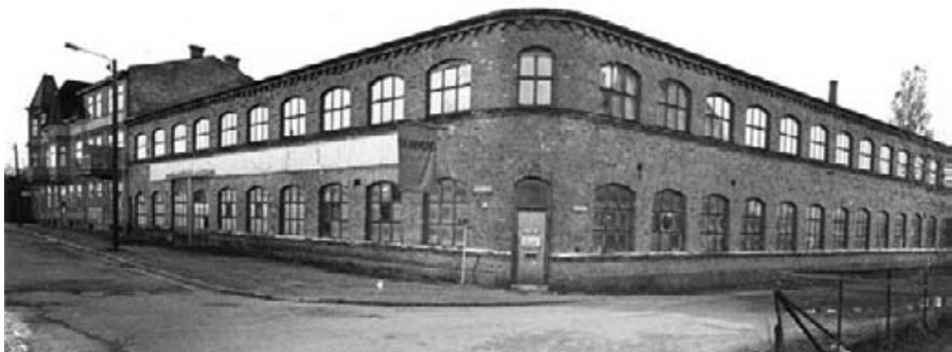
Längst upp, "von Post-huset" som låg i korsningen Vänerslundsgatan/Kroppkärrsvägen. På bilden under ses Walfrid Svenssons möbelfabrik. Båda byggnaderna var återuppbyggda redan ett år efter branden. Möbelfabriken eldhärjades även vid ett par tillfällen på 1940-talet. Adressen idag är Tolvmansgatan 13. Foto: SN
