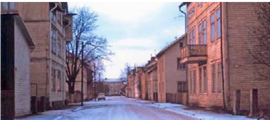
Hantverkargatan före rivningsvägen. Andra huset på höger sida är Hantverkargatan 20. Foto: Kjell Rydahl
