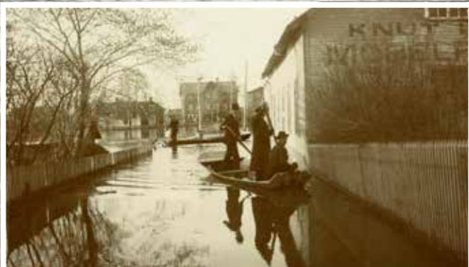
Knut Liljas Möbelfabrik på Hagaborg. FOTO: KARL NYSTRÖM
