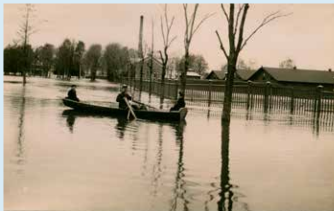
Sandgrund var helt översvämmat och man fick använda eka för att ta sig ut till Vattenverket. FOTO: CARLSTADS-GILLET'S SAMLINGAR
