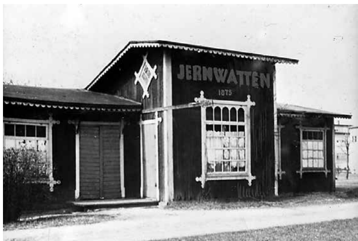
Sundstas Vattenfabrik varifrån vatten fördes i rör över älven till Dahlgrens brunnsanstalt.
