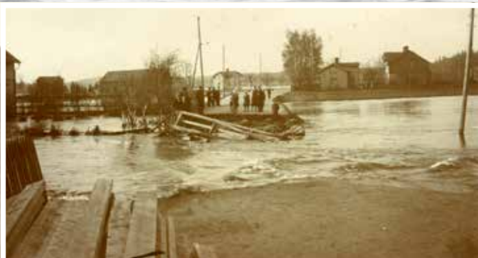
Landsvägen, nuvarande Lagmansgatan nära uppfarten mot Hagaleden, rasade av vattenmassornas tryck och skapade en öppning på 24 meters längd och fyra meters djup. Hålet fylldes senare med sandsäckar och en provisorisk bro byggdes.
