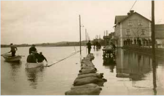
”Den kloka åtgärden att lägga ut sandsäckar till fördämning längs ena kanten af Färjestadsvägen visade sig vara till stor nytta för de översvämmade stadsdelarna.” FOTO: KARL NYSTRÖM
