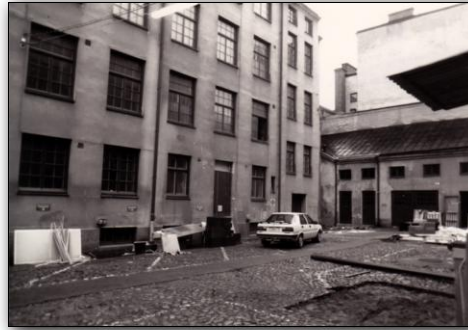
Drottninggatan 12 inför rivning 1987
