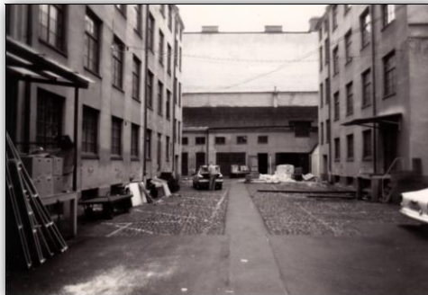
Drottninggatan 12 inför rivning 1987
