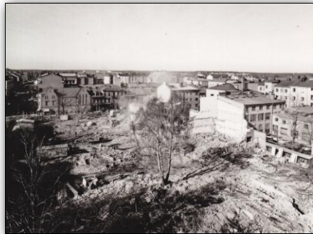
Rivning i kvarteret Freja mot Drottninggatan 1964
