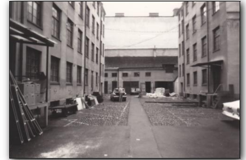
Drottninggatan 12 inför rivning 1987
