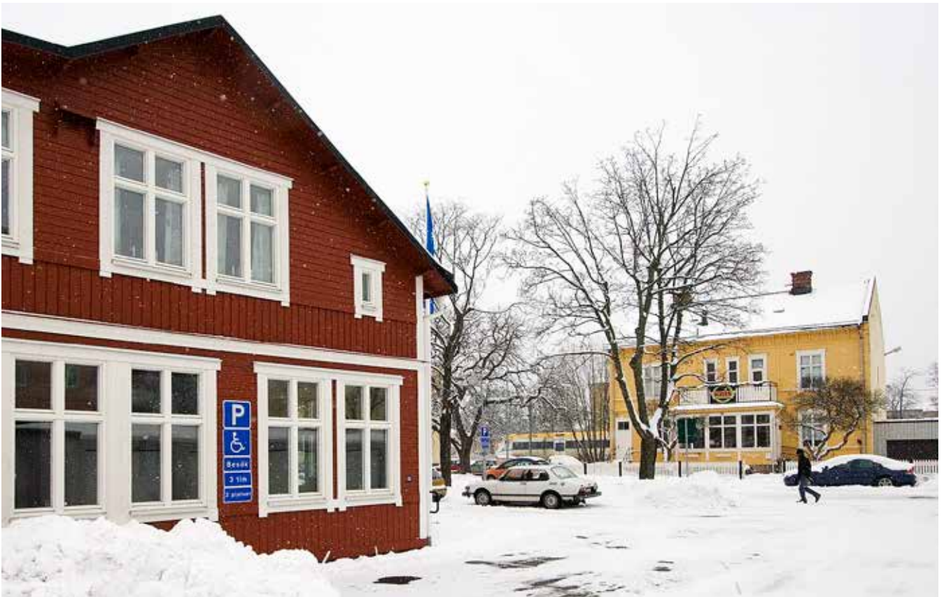
Återstoden av C J Wennbergs Mekaniska Verkstad, den röda kontorsbyggnaden, som ligger mitt emot Gula villan på Vikengatan, sparades när själva verkstaden revs för att ge plats åt ett bostadshus
