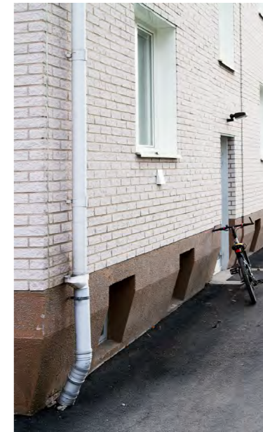
Exempel på hur fasaden förfulades genom djupa fönsternischer och onaturlig grundläggning då man tilläggsisolerade i samband med ROT-renoveringarna på 1980-talet.
